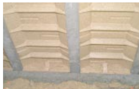
Bonne étanchéité au coulage
