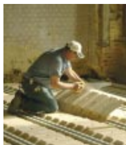
Découpe facile à la scie égoïne pour ajuster les longueurs
