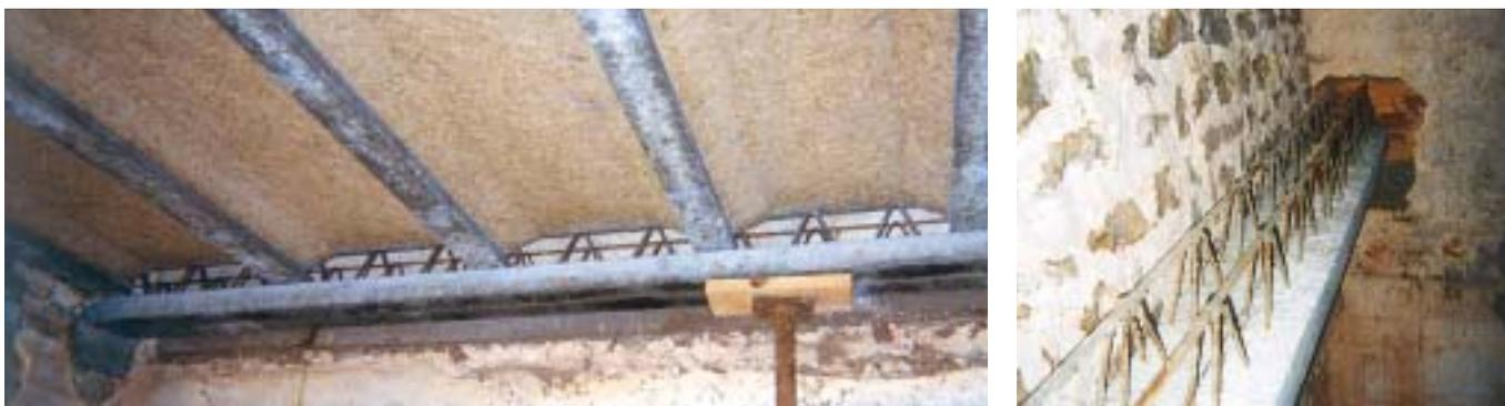
En premier lieu, la légèreté des composants RECTOR (Poutres Plates PPR, poutrelles et entrevous), en diminuant fortement le poids propre du plancher, sollicite moins les fondations qu'une dalle coulée en place et évite souvent de renforcer la structure du bâtiment.
