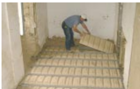
Mise en œuvre facile et rapide : pose réalisée en 3 heures
