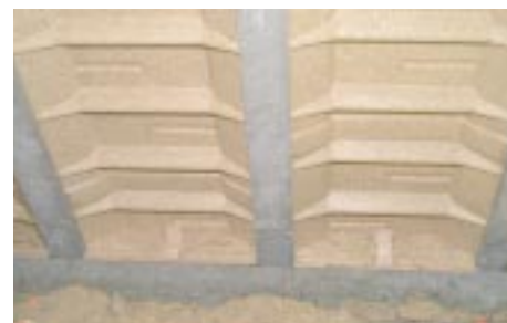
Bonne étanchéité au coulage
